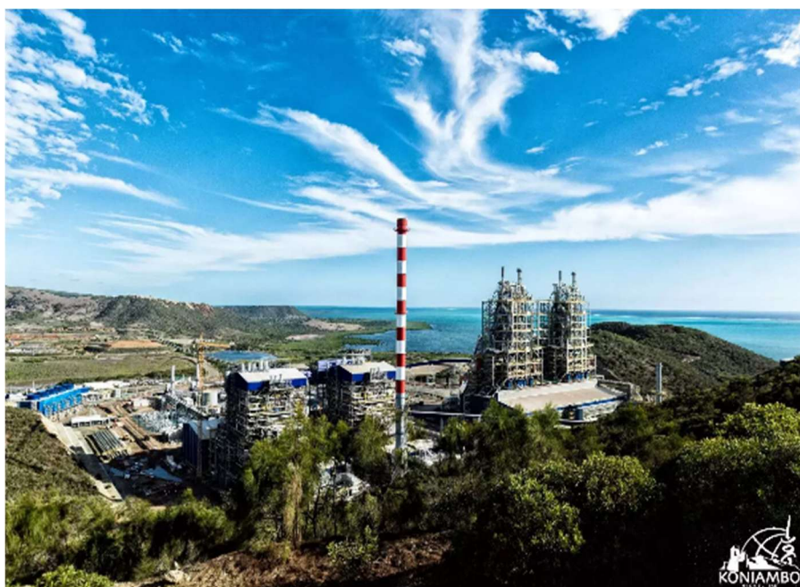
La Centrale électrique de l'usine Koniambo
