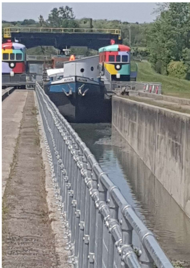
Vue de la rigole vers l'aval
