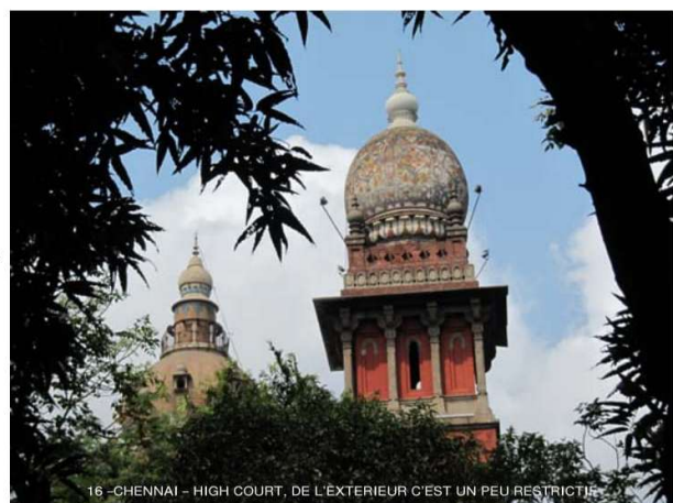
16 - CHENNAI - HIGH COURT, DE L'EXTERIEUR C'EST UN PEU RESTRICTIF
