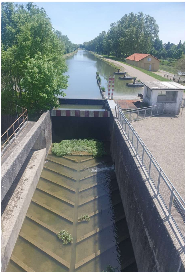
Vue de la rigole vers l'amont
