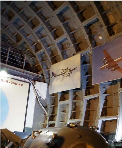
Les tunnels sont constitués d'une enveloppe métallique dont les éléments sont boulonnés entre eux ; comme illustré sur le cliché à gauche, pris dans le bunker de Taganka, construit par Staline à 60m sous le niveau de la rue et particulièrement utilisé durant la guerre froide.
