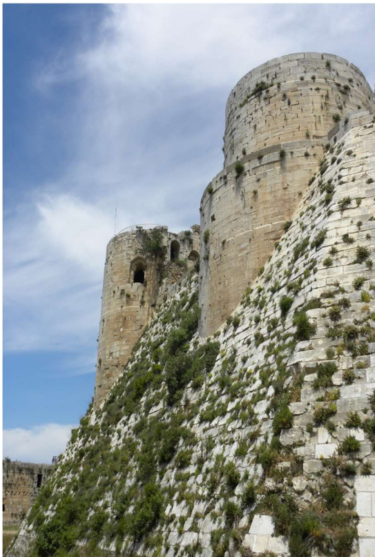
Vue de l'extérieur sur les donjons et murs de fortifications.
