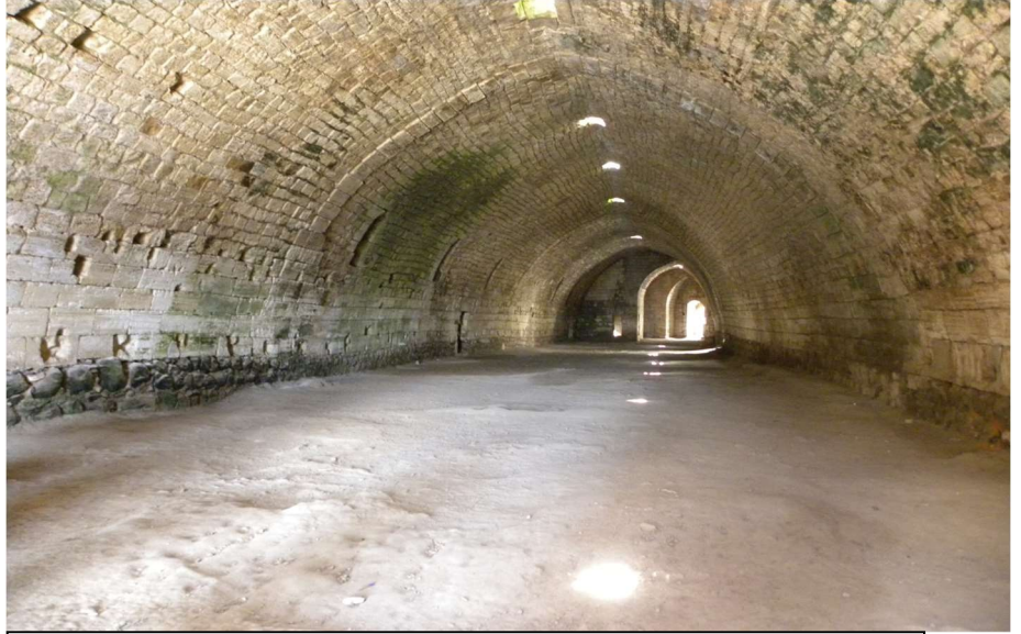
Salle voutée servant de passage entre la première et la deuxième enceinte.
