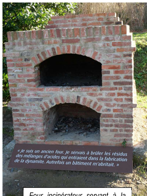
Four incinérateur servant à la destruction des résidus acides
