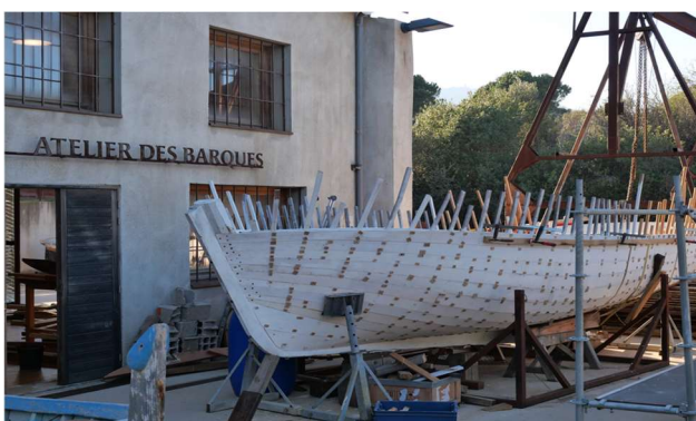
L'atelier de restauration des barques catalanes
