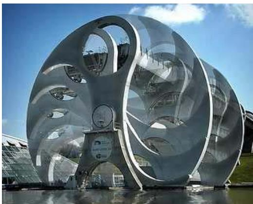
La roue peut tourner dans les deux sens au choix de l'opérateur. La manœuvre complète dure 15mn dont 5mn30 pour la rotation.
