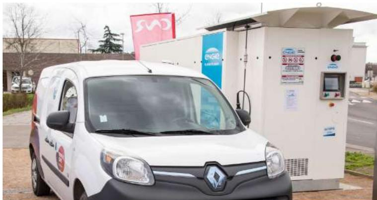
A Lyon McPhy a livré en 2018 à la Compagnie Nationale du Rhône et Engie une station installée au sein du port Édouard Herriot à Lyon. Cette station a une capacité de 20 kg/jour pour de l'hydrogène à 350 bars
