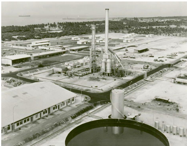
Photo 3- Raffinerie d'Abidjan durant la construction
