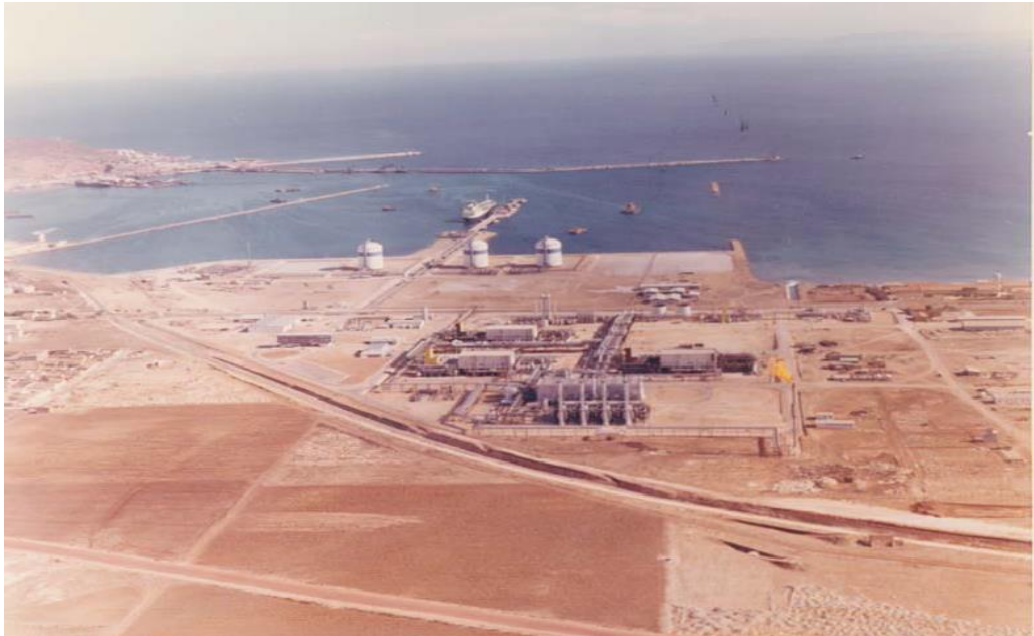
Photo 4 –La CAMEL en construction, vers 1964
